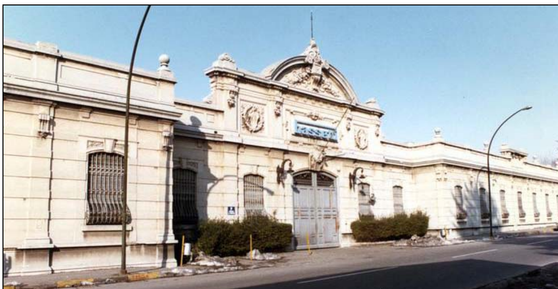
Fig.3 Edificio storico Bassetti
